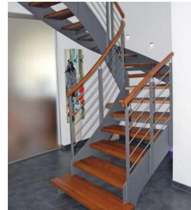
Flachstahlwangentreppe, Holzart amerikanischer Nussbaum, Rellingeländer mit Flachstahlpfosten mit Holzhandlauf
