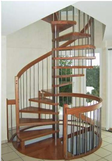
Spindeltrappe Typ STH, Holzart Amazakoue, Spindel- und Distanzhülsen Edelstahl, Geländer Es1
