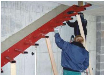
Montage der Stahlkonsolen für die Kragarmtreppe
