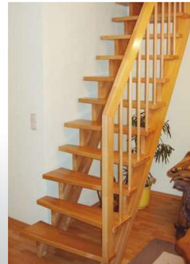
Wangentreppe aufgesattelt mit Trapezstufen, Holzart Buche keilg., Handlauf unter der Decke abgeknickt, Geländerstab DG 1
