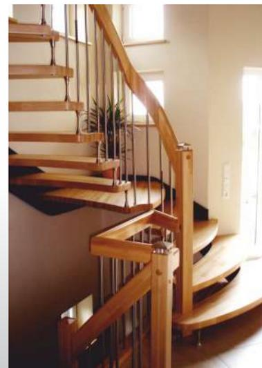
Kombination Flachstahlwange mit Bolzentreppe, Holzart Buche keilgezinkt, Bolzenkette Edelstahlhülse
